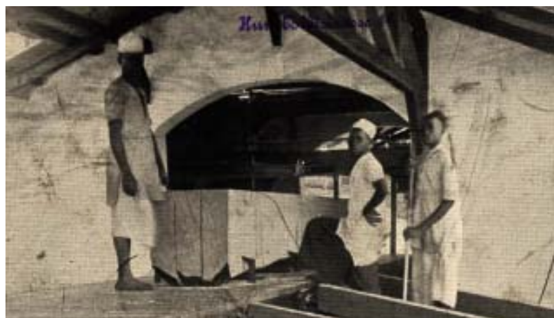
Besonders häufig wurden Tischlereien eingerichtet.
